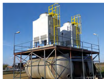
Wet cooling tower, Bonduelle Nyírszőlős, Hungary
