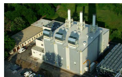
Электростанция Уйпалота (Újpalota)
